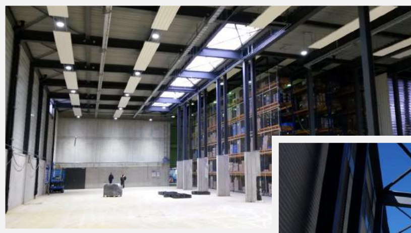
Neubau Verwaltungsgebäude | Erweiterung Lager, Steinenbronn
