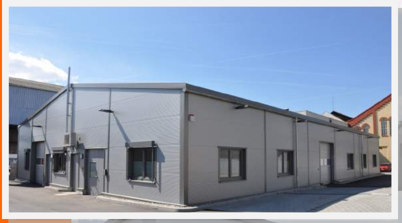
Neubau Zustellstützpunkt, Süssen
